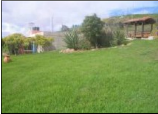
Figura 27. Tanque Oriente y Bombeo La Fuente
