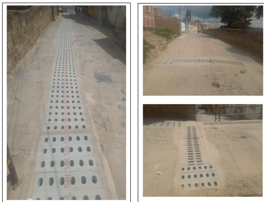
Figura 78. Canales construidos
