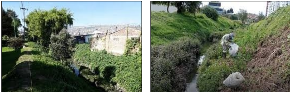
Figura 135. Estado de ocupación del cauce del río Jordán
